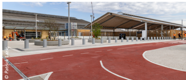
Des espaces mieux indiqués pour sécuriser les piétons et les cyclistes
