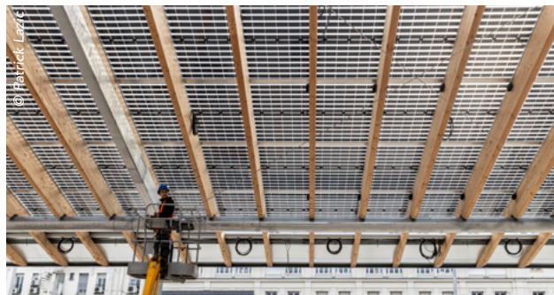
Pose des panneaux photovoltaïques
