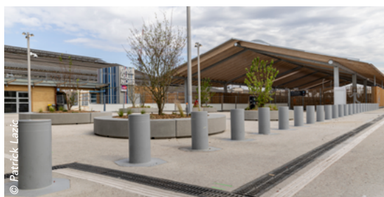
La nouvelle halle à vélos et le parvis haut
