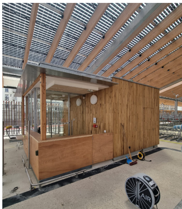
Bulle d'accueil de la halle à vélos : bardage bois avec le parquet récupéré d'un autre bâtiment SNCF
