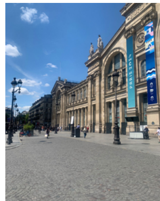
Un parvis pacifié et apaisé par la suppression d'une voie
