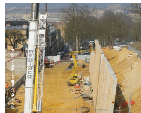
Construction du mur, 2014
