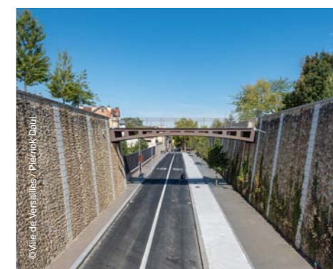
Vue de la traversée, 2019
